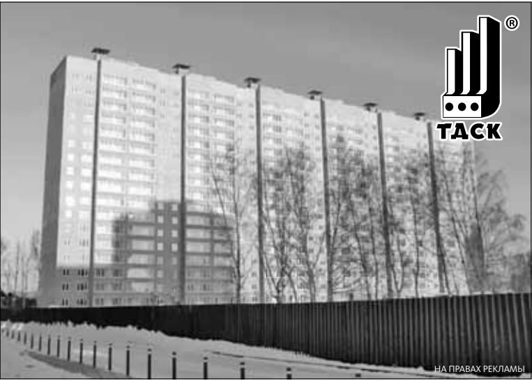
■ В начале апреля состоялось заселение дома по ул. Береговой, 17, в жилом комплексе Радонежском
