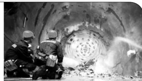
чивается в породу и благодаря винтовым лопастям продолжает движение в среде. И если существующие аналоги работают на границе сред – воздушной и твердой, то «Геоход» движется в твердой среде, используя ее для создания так называемого напорного усилия, чтобы обеспечить себе продольное перемещение – в этом его уникальность. Так летит самолет, опираясь на воздушную среду.
