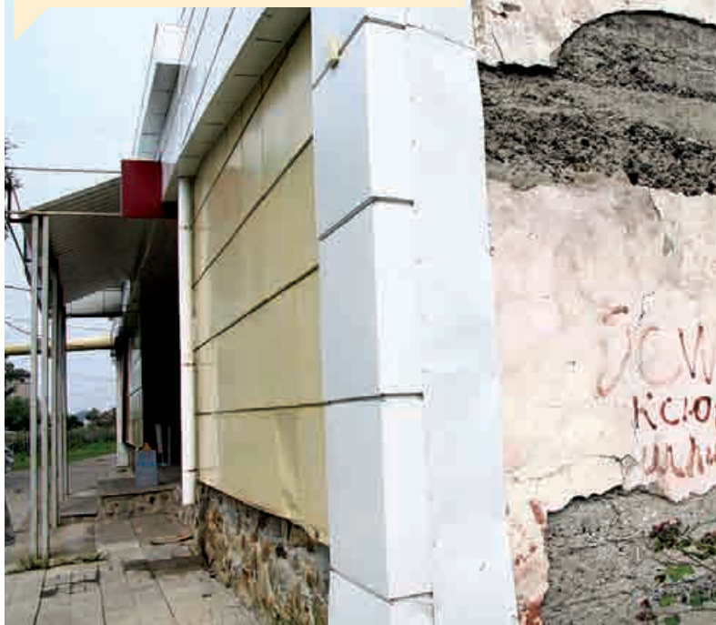
■ Дом культуры пос. Зональная Станция
